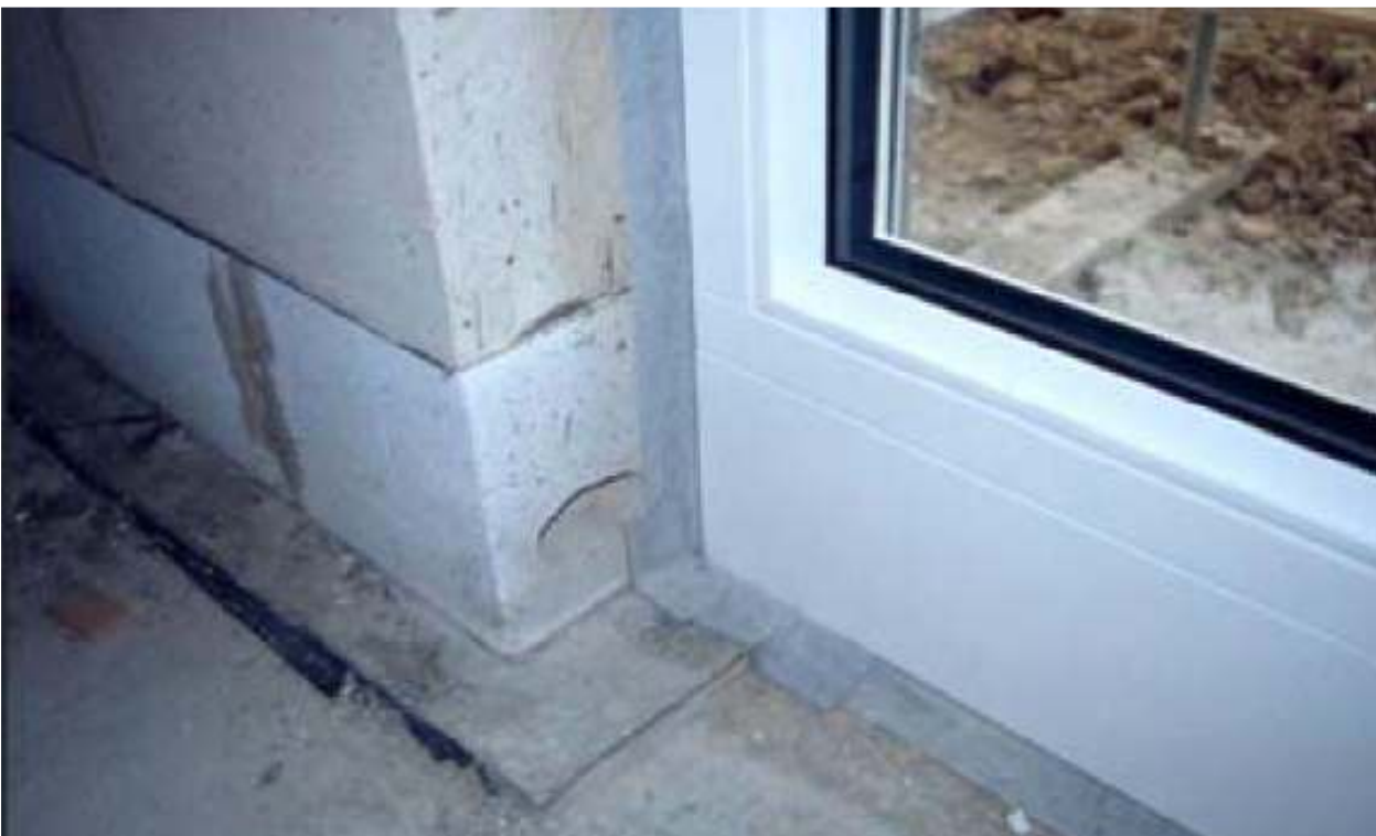
Abbildung 31: Luftdichte Verklebung innen - eingebautes Fenster [B. Schulze-Darup] in [HOL07]
