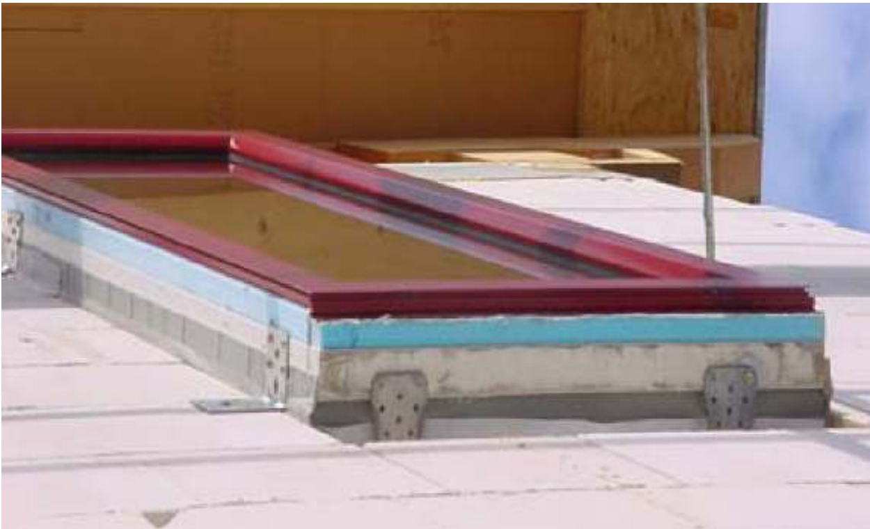
Abbildung 28: Einbau in der Dämmebene [B. Schulze-Darup] in [HOL07]
