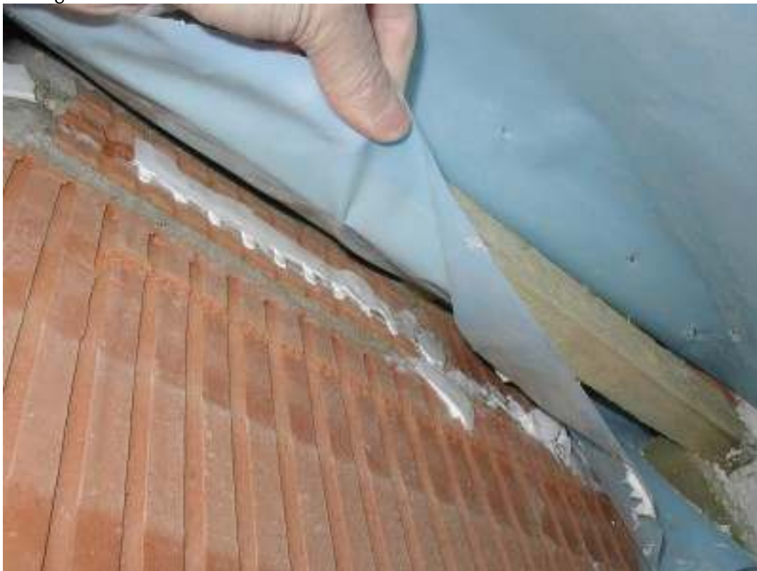
Abbildung 19: Negativbeispiel I – absolut mangelhafter Anschluss der Dampfbremse (luftdichte Ebene) an das angrenzende Mauerwerk [TRA08]
