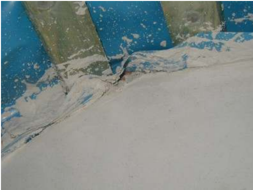
Abbildung 20: Negativbeispiel II – absolut mangelhafter Anschluss der Dampfbremse (luftdichte Ebene) an das angrenzende Mauerwerk [TRA08]
