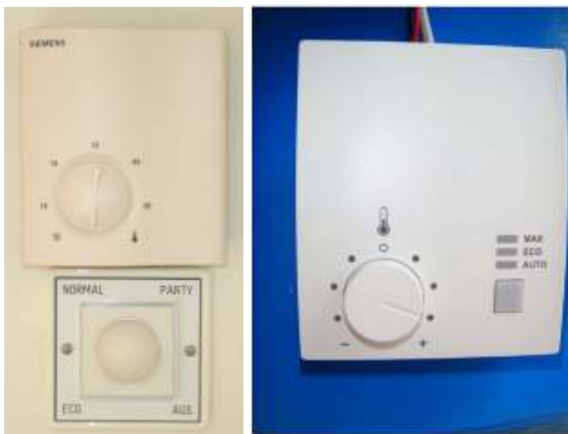
Abbildung 10: Mögliche Bedienelemente zur Regelung der Luftmengen und der Raumtemperatur
