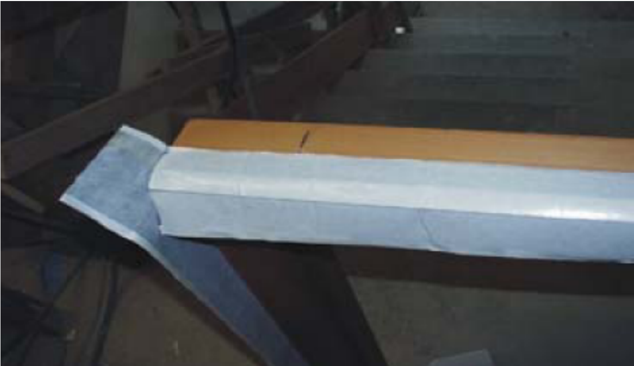
Abbildung 30: Luftdichte Verklebung innen - Aufbringung der Dichtfolie am Fensterstock vor Einbau [B. Schulze-Darup] in [HOL07]
