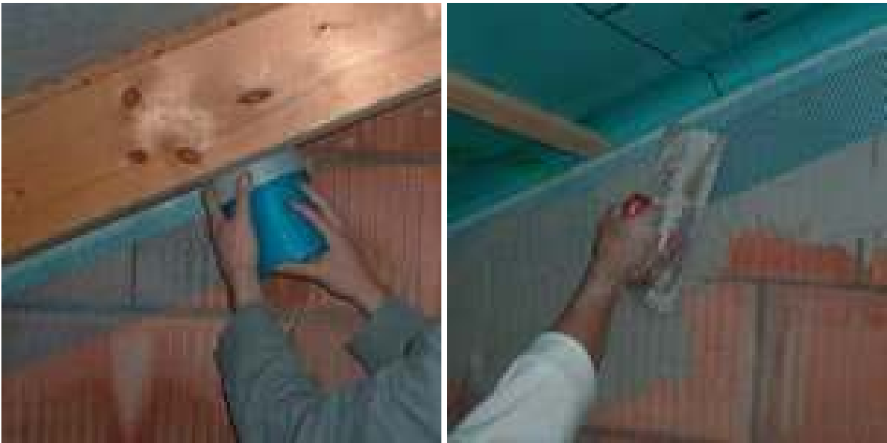
Abbildung 22: Vorgefertigte Systeme mit Klebestreifen zum Anschluss an die Folie und Streckmetall für den Anschluss zum Putz [MOL08] in [TRA08]
